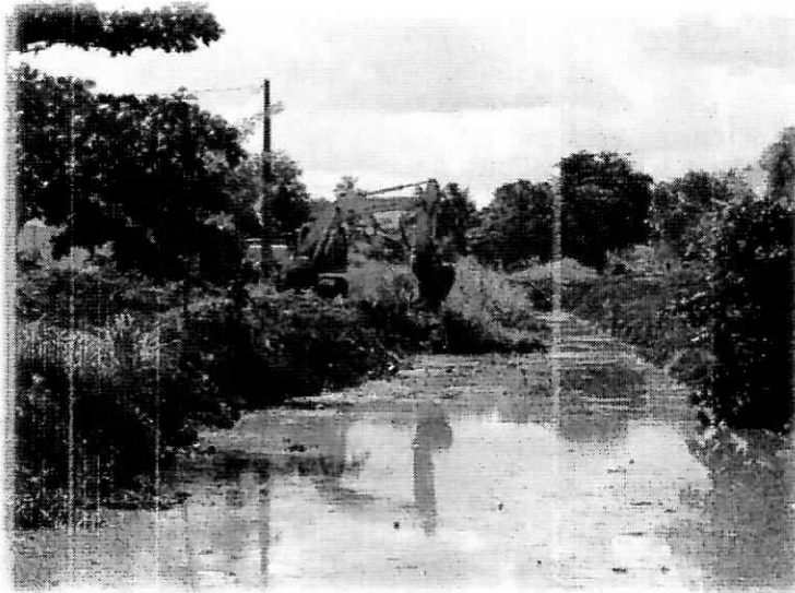
Figura 33 - Limpeza córrego Mutuca
