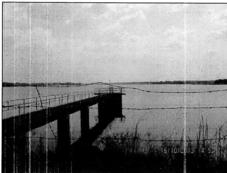
Figura 23. Ponto de captação de água - Córrego Bananal.
