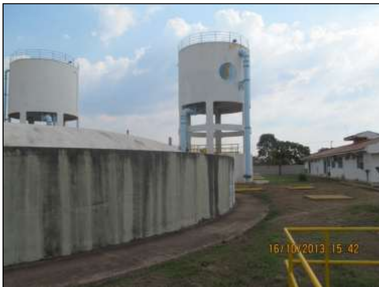
Figura 25. Vista parcial da ETA 001.
