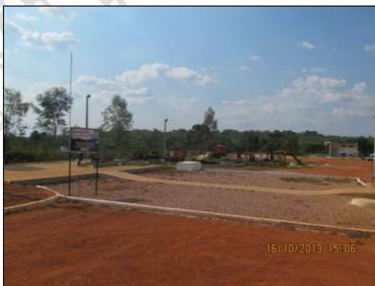
Figura 27. Vista parcial da ETE.
