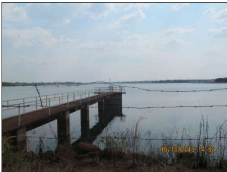
Figura 23. Ponto de captação de água - Córrego Bananal.
