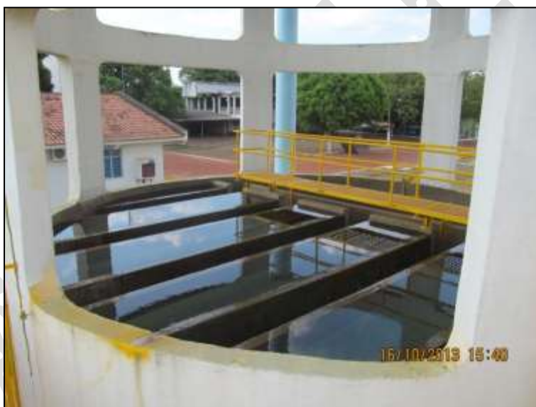
Figura 26. Filtro Russo de Dupla Filtração.
